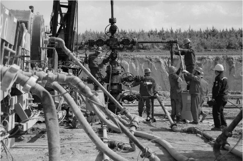
图为压裂队员正在安装放喷油咀。
