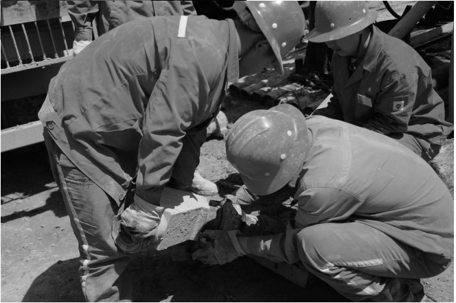
图为压裂队员正在安装连接管线。
