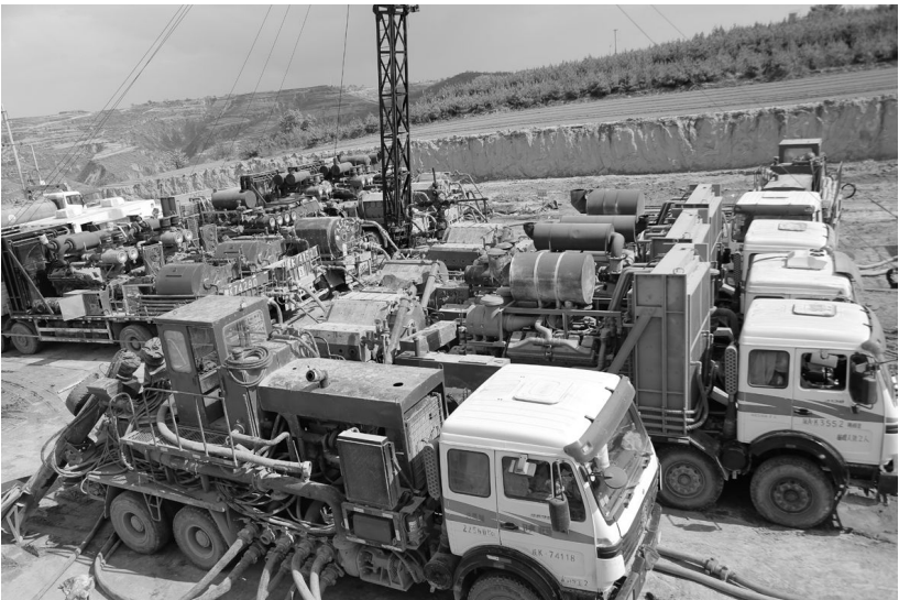
井场内机器轰鸣,压裂车正在进行压裂施工。
