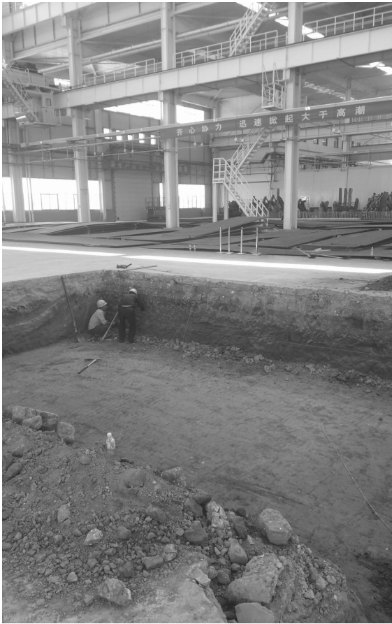
根据钢结构生产加工需要,兼顾车间长期规划,机械公司决定在容器厂房第四跨修建喷砂房一间,现正在进行地基开挖。(王尧 摄)
