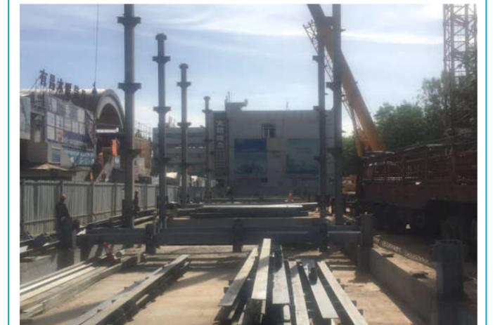
近日,解放东路立体停车楼工程项目正在有序推进,目前已基本完成基坑四周土方回填工作,停车楼钢结构准备正式开始安装。
